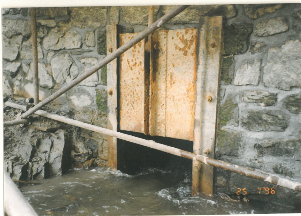
28. Otevřená tabule základové výpusti před montáží vtokových česlí. Vpravo ve styku hladiny se zdivem je znatelná příčina průsaku.
