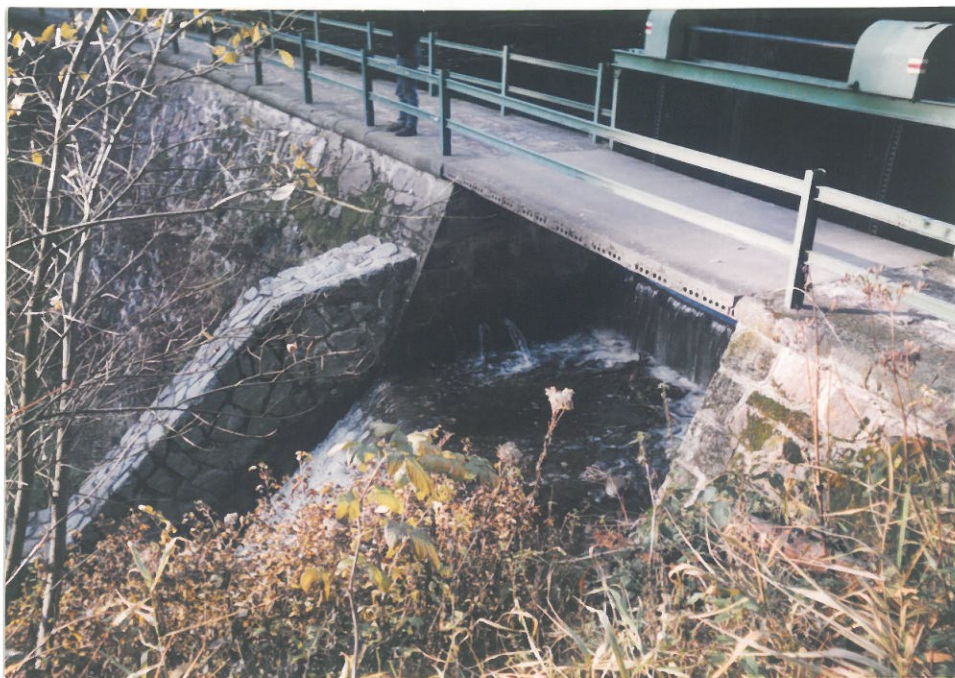
13. Průsaky z pilíře bezpečnostního přelivu při kótě hladiny 355,72 dne 31.10.94 (po pro- vizorní opravě)
